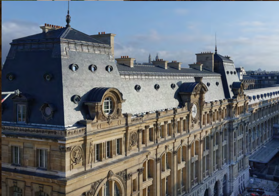
GROUPE BALAS, RESTAURATION DES COUVERTURES DE LA GARE DE PARIS SAINT-LAZARE © AUGUSTO DA SILVA
