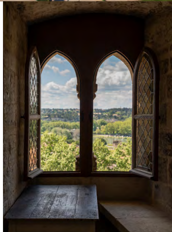
ATELIER DE LA BOISERIE, RESTAURATION DES FENÊTRES AU PALAIS DES PAPES D'AVIGNON © ATELIER DE LA BOISERIE
