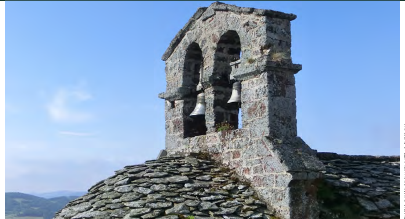
TOIT DE LAUZ DE LA CHAPELLE DE ROCHEGUE (HAUTE-LOIRE) © DR
